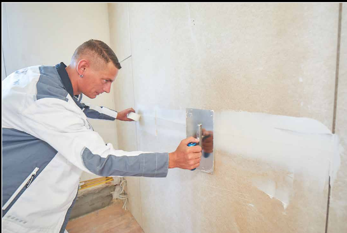
Stephan Falk (D) liefert mit dieser Aufnahme einen wertvollen Einblick in die Arbeit eines Trockenbauers. Dessen Aufgabe ist es, die auf Stoß montierten Gipsfaserplatten so zu verspachteln und mit Gewebeband zu armen, dass die Fugen nicht mehr sichtbar sind. Eine fertige Trockenbauwand darf nicht als solche erkennbar sein, das ist letztlich das Undankbare an dem Beruf
